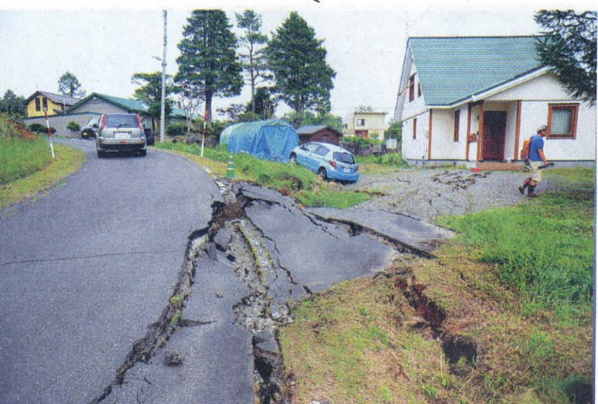
地面に亀裂が走った厚真町のルーラルビレッジ
