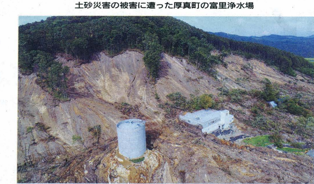
土砂災害の被害に遭った厚真町の富里浄水場
