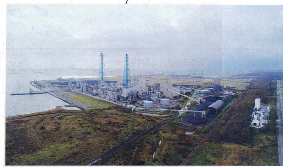
タービン火災などで緊急停止し、大規模停電の引き金になった苫東厚真火力発電所
