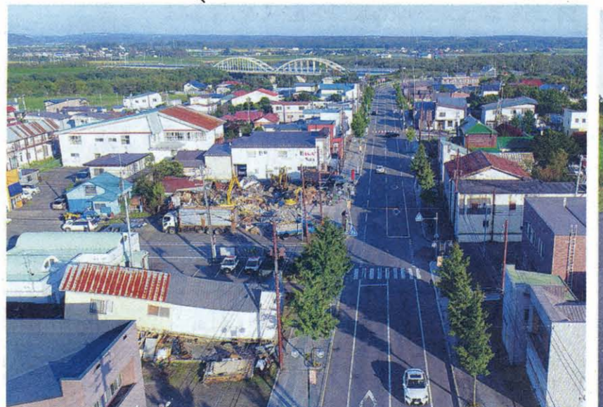
倒壊など多数の建物被害が出たむかわ町の中央通り
